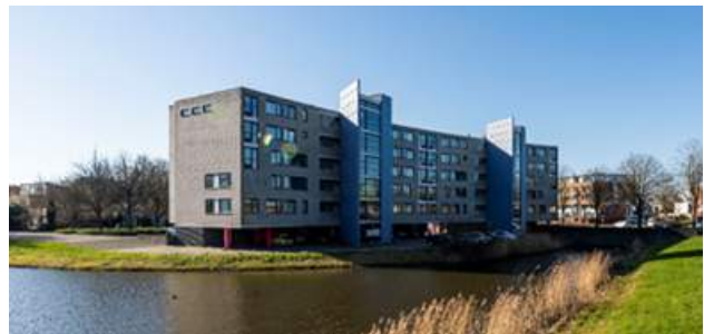
Aangekocht complex aan de Golda Meirstraat in Groningen
